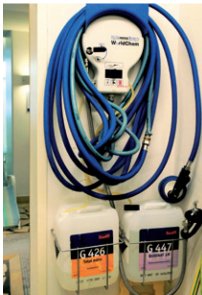
Dosieranlage für die buzil-Produkte G 426 Total extra und G 447 BUDENAT® LM
